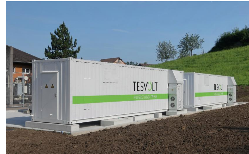
Batteriespeicher (Quelle: [7])
