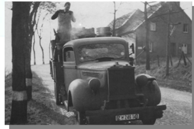
Ford-LKW mit Imbert-Generatoranlage
