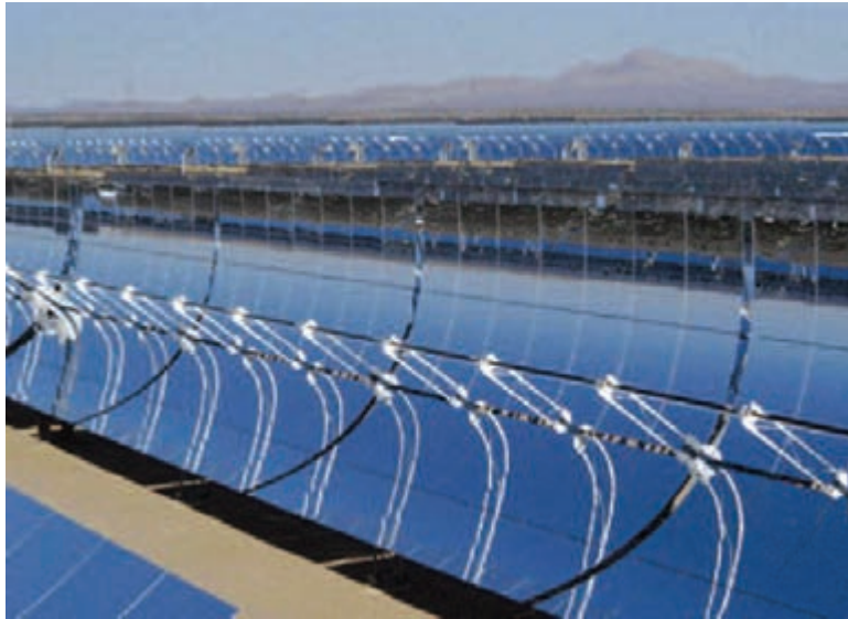
Abbildung 3 Solarthermisches Kraftwerk Andasol in Spanien. Das FVS- Institut DLR entwickelt Methoden zur Justage der Spiegel.
