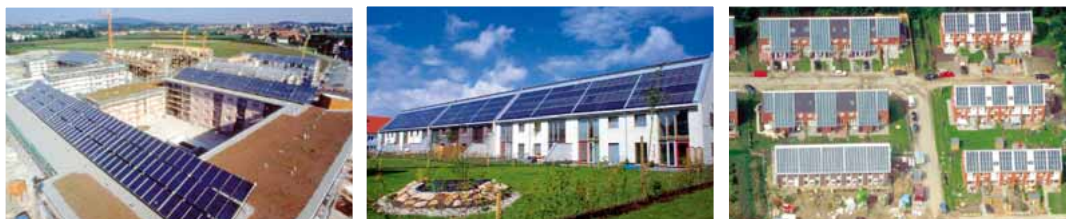
Friedrichshafen-Wiggenhausen (1996) 380 Wohnungen, 4.050 m 2 Flachkollektor, 12.000 m 3 Heißwasser-Wärmespeicher
