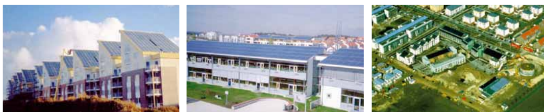
Rostock-Brinkmannshöhe (1996) 108 Wohnungen, 1.000 m 2 Flachkollektor, 20.000 m 3 Aquifer-Wärmespeicher
