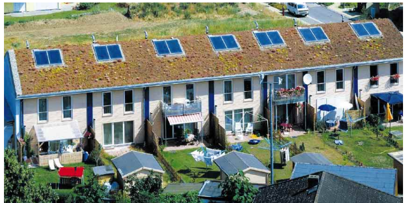
Die Gebäude werden mit finanzieller Förderung der Energiestiftung Baden-Württemberg und der EnBW über zwei Jahre vermessen. Basis der Wärmeversorgung sind jeweils dezentrale Lüftungs-Kompaktgeräte und Solaranlagen.
