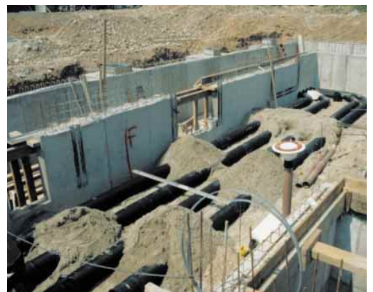
Ein Register aus 7 je 100 m langen Polyäthylen-Rohren mit je 250 mm Nennweite kühlt (Sommer) und wärmt (Winter) den Zuluftvolumenstrom von 3.000 bis 6.000 m 3 /h zu einem Vortragsraum und einem Atrium. Das Bild zeigt 4 der 7 Rohre während der Verlegearbeiten.
