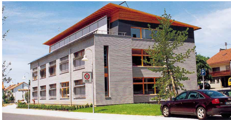
Abbildung 11 Bürogebäude der Lamparter GbR, Weilheim (Architektur: Werkgemeinschaft Maier-Weinbrenner- Single, Nürtingen).
