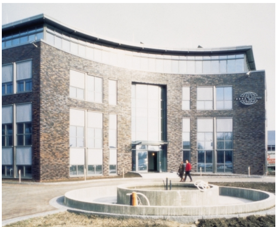
Abbildung 6: Die Produktionshalle der Firma Hübner in Kassel-Walden
