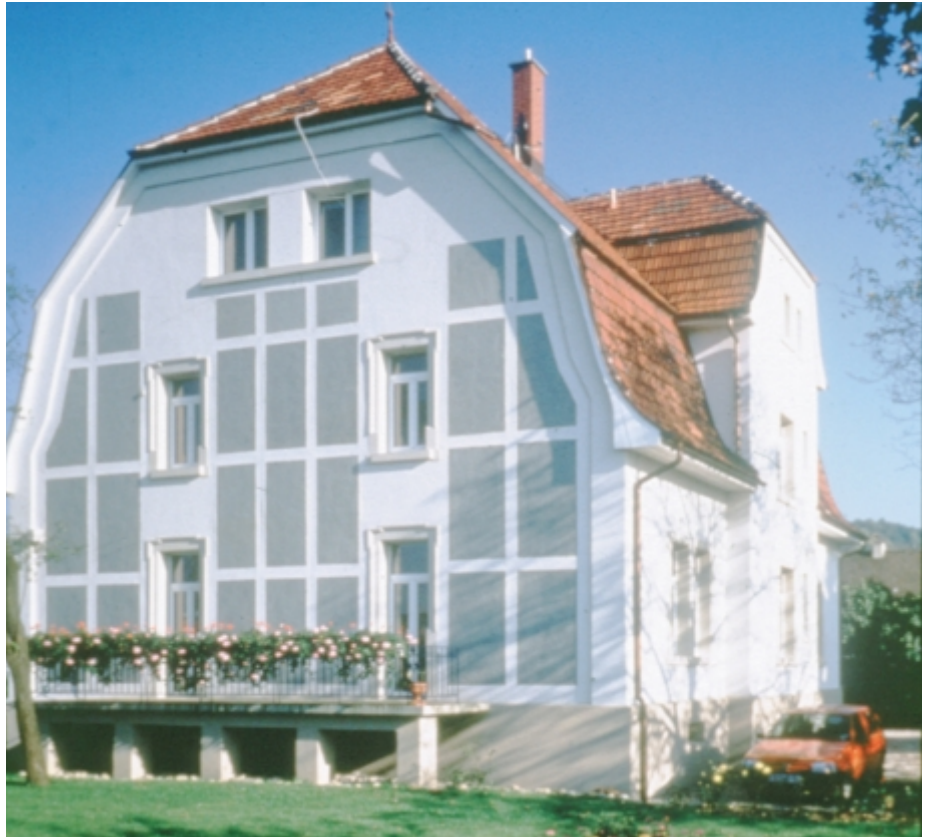
Abbildung 5: Transparentes Wärmedämm-Verbundsystem an einem Gebäude aus der Gründerzeit, die „Villa Tannheim“ in Freiburg
