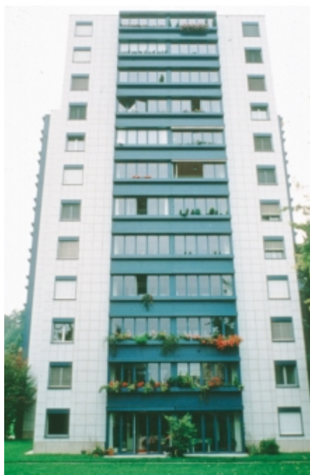
Abbildung 3: Verglasung der Balkone bei einem 12-stöckigen Wohnhaus in Glattbrugg (Schweiz)
