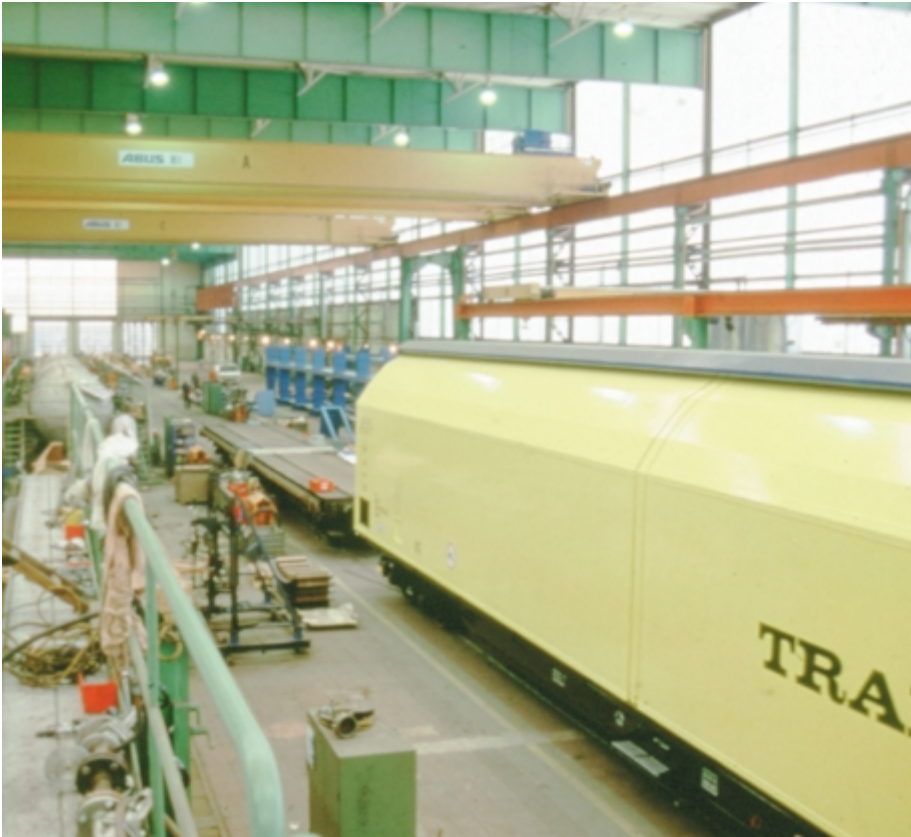
Abbildung 9: 7000 m 2 TWD-Glaswand (rechts im Bild) bei der Sanierung der Fertigungshallen der Linke-Hofmann-Busch GmbH in Salzgitter
