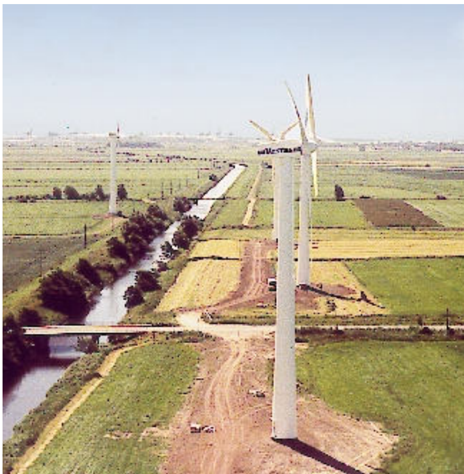
Der Windpark Wremen-Grauwallkanal zwischen Bremerhaven und Cuxhaven mit sieben Vestas V39/500kW Anlagen; Inbetriebnahme Juni 1994, Jahresertrag ca. 13,5 Mio kWh
