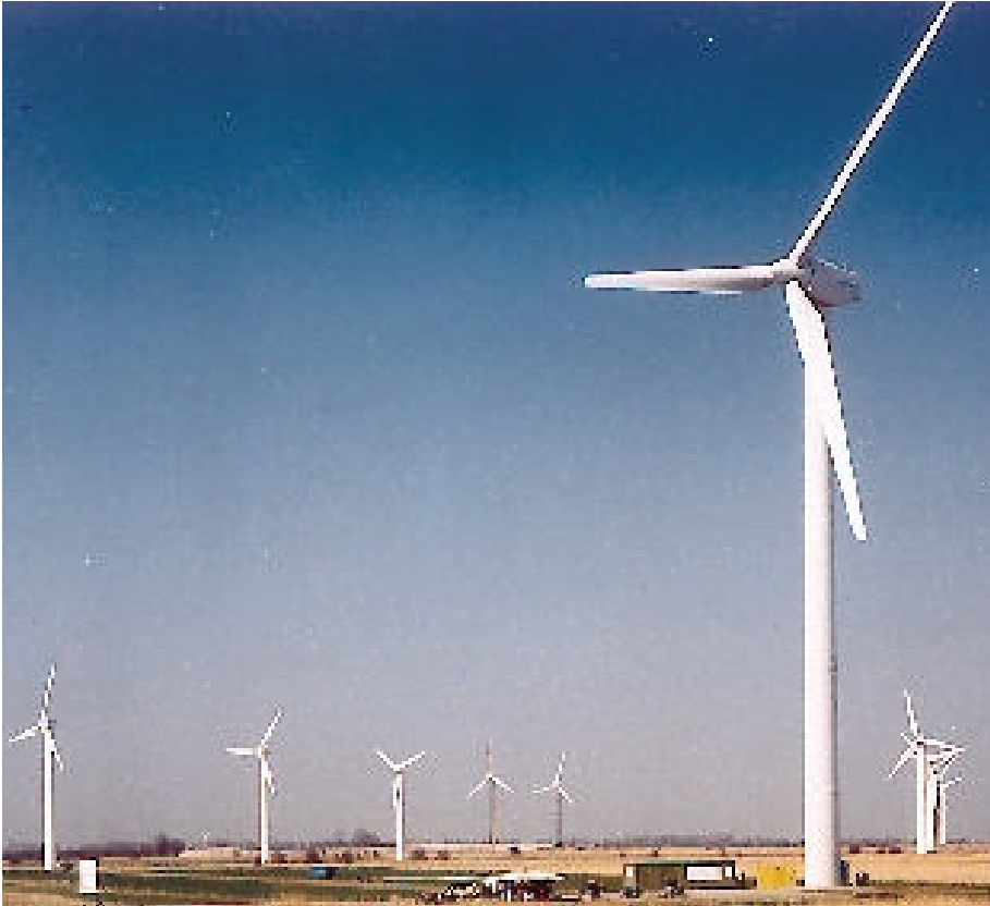
Abbildung 1: Großwindkraftanlage TW 1.5 der Tacke Windtechnik GmbH. Eine Anlage dieses Typs wird mit der neuen Regelungstechnik sowie einem Fehlerfrüherkennungssystem ausgestattet.
