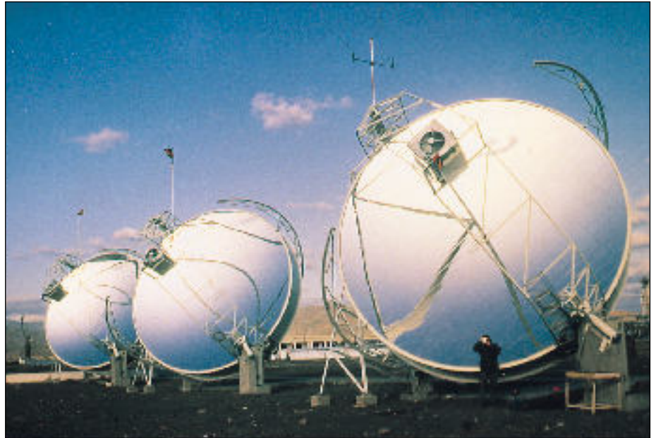
Abbildung 2: SBP 9 kW Dish/Stirling Einheiten in Almería
