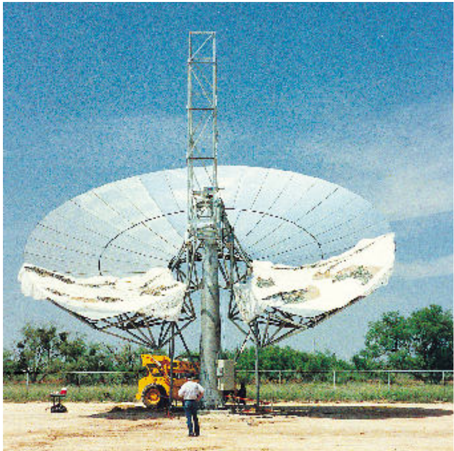
Abbildung 6: 25 kW el CPG Konzentrator
