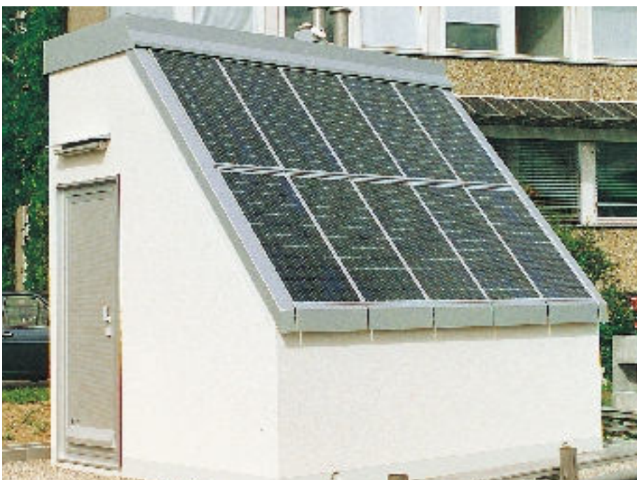
Abbildung 3: Kompaktes PV-TE-Hybridsystem mit integriertem Solargenerator zur Versorgung von Telekommunikationseinrichtungen
