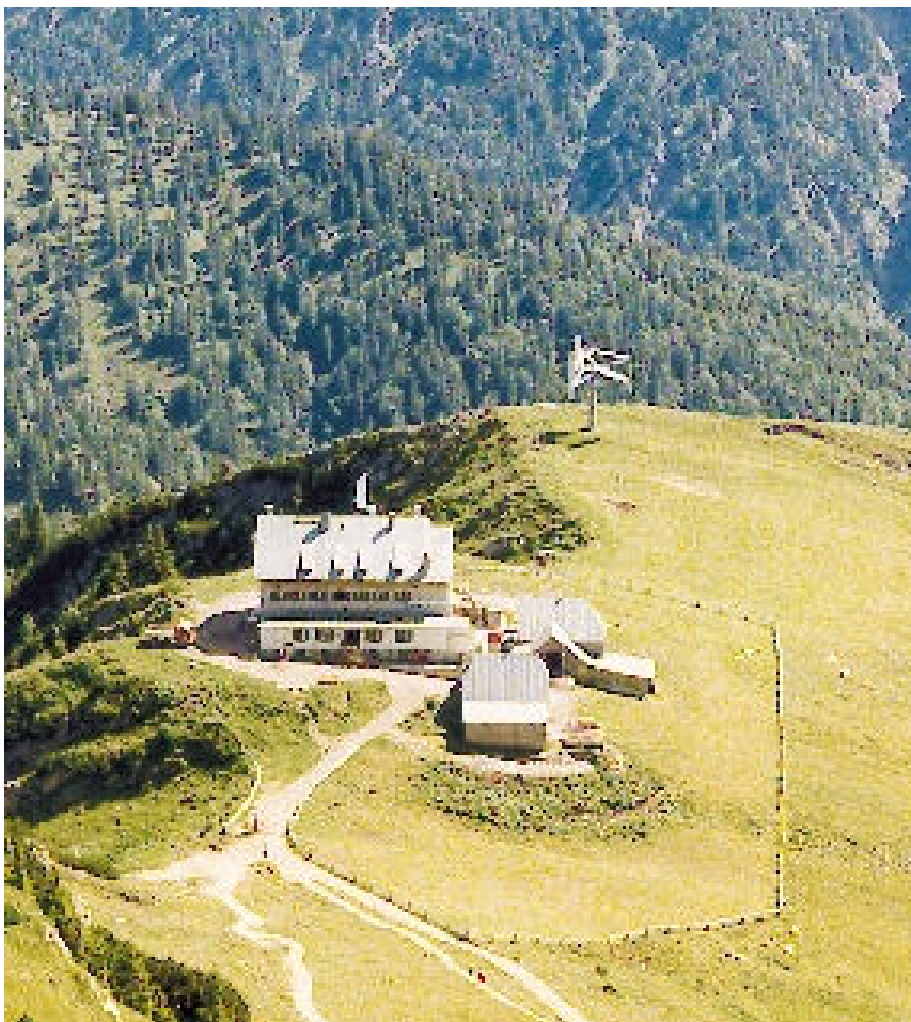
Abbildung 3: Das Rotwandhaus des Deutsche Alpenvereins wird durch ein PV-Wind-Diesel-System mit elektrischer Energie versorgt.
