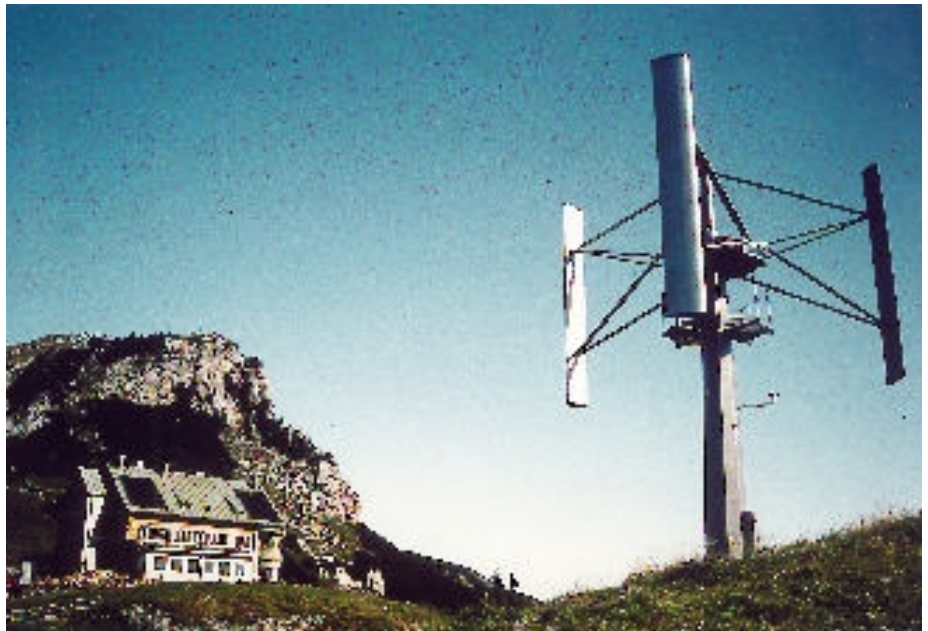
Abbildung 9: Rotwandhaus mit Solargenerator und Windkraftanlage
