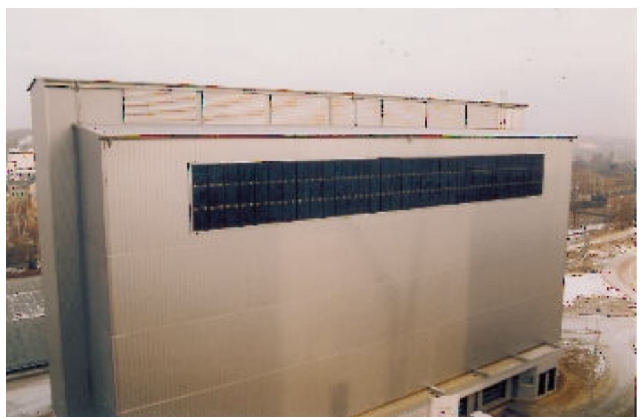
Abbildung 12: Südansicht des vollautomatischen Parkhauses in Chemnitz mit in die Gebäudehülle integrierter 10 kW p Photovoltaik-Fassade
