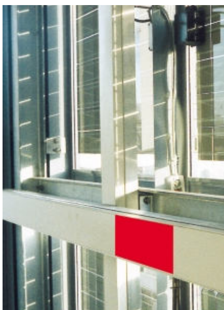
Abbildung 4: Matrixinstallation mit modulatorientiertem Stromrichter (hier RIC - Room-In-Converter)
