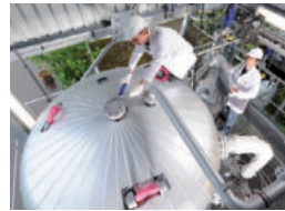
Variabler Speicherteststand mit austauschbarem Behälter
