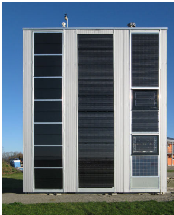
Abbildung 2 PV-Testfassaden am Fraunhofer IWES
