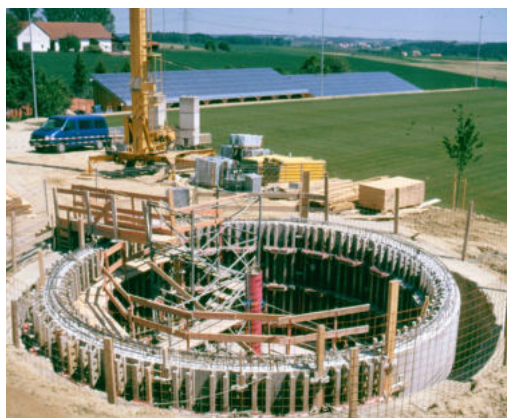
Abbildung 2 Erdbeckenspeicher des Projekts „Solare Nahwärme Attenkirchen“
