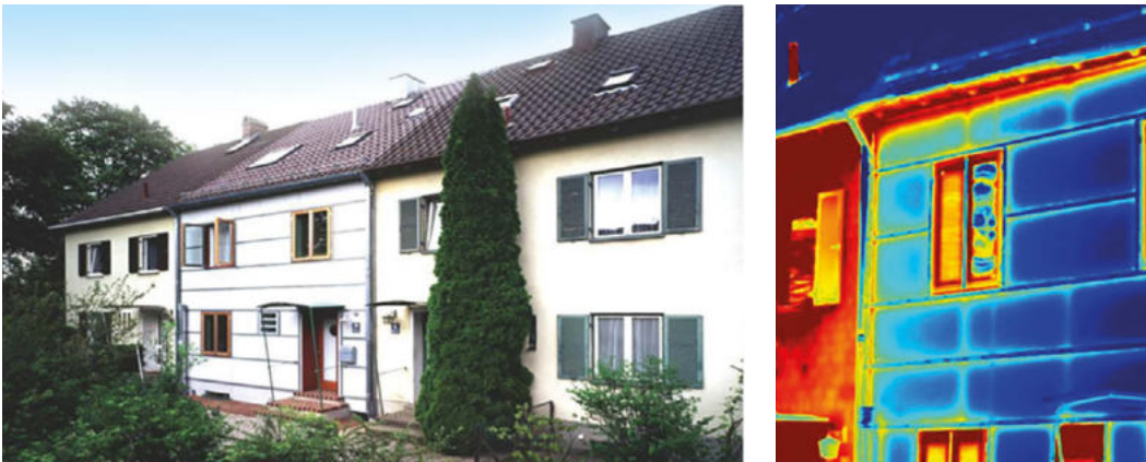
Abbildung 1 Mit Vakuumisulationspaneelen energetisch saniertes Reihenmittelhaus
