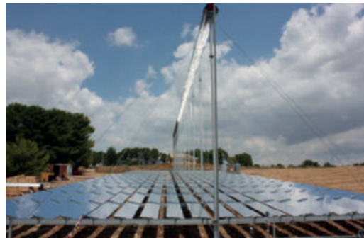
Abbildung 5 Parabolrinnen- und lineare Fresnel- Kollektoren
