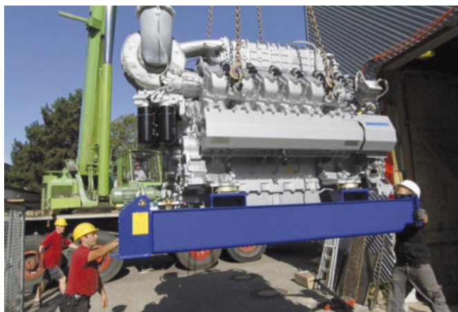
Abbildung 2 Anlieferung neue BHKW-Blöcke
