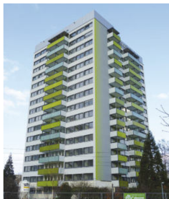
Abbildung 3 Erneuerte Fassade mit 200 mm WDVS, Dreifachverglasung und thermischer Trennung der Balkone; Einsatz von Aerogeldämmplatte
