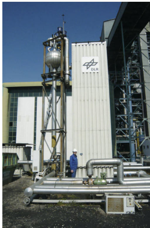
Abbildung 5 700 kWh Latentwärme-Pilotspeicher im Wasser/Dampfkreislauf
