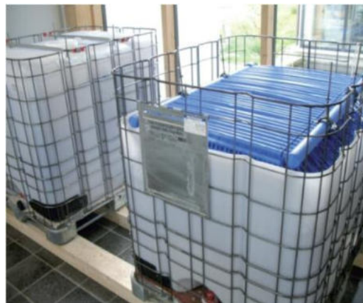
Latentwärmespeicher mit Calcium-Chlorid zur Rückkühlung eine Absorptionskältemaschine zur solaren Klimatisierung (ZAE Bayern)
