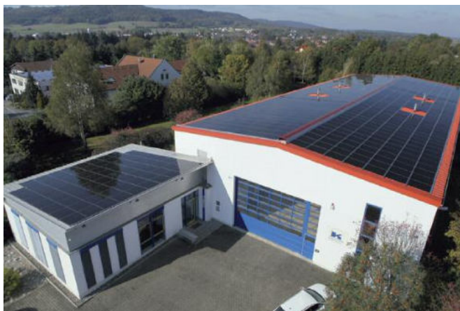
Abbildung 3 Dachanlage auf einer Gewerbehalle in Turnau mit \alpha -Si/ \mu -Si-Modulen (Foto: Inventux)
