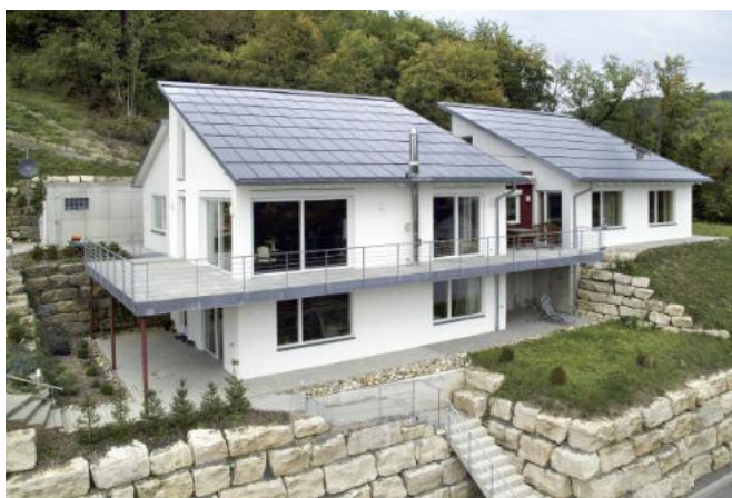
Abbildung 4 Dachintegration von CIGS-Modulen (Foto: Würth Solar)
