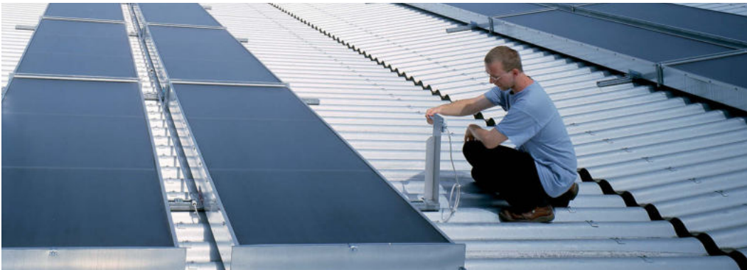
Solaranlage der IHK Freiburg © Fraunhofer ISE
