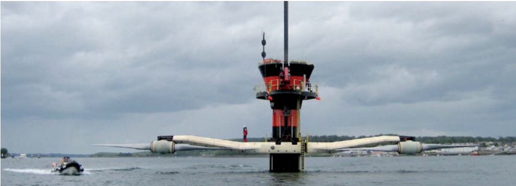
Gezeitenströmungskraftwerk „SeaGen“, Leistung 1,2 MW Quelle: Fraunhofer IEE
