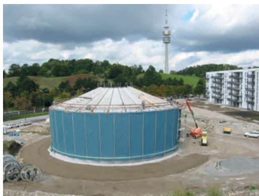
Bau eines saisonalen Wärmespeichers für ein solares Nahwärmenetz © ZAE Bayern
