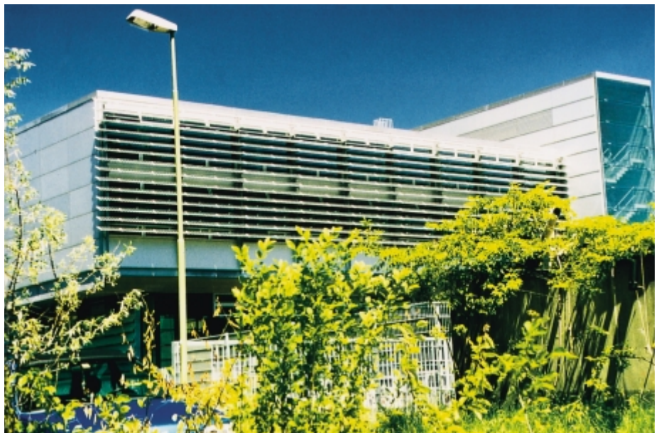
Abbildung 2: Fassadenansicht einer Photovoltaik-Beschattungsanlage. Die Solarzellen sind auf einem transluzentem Gewebe zwischen zwei Glaslamellen einlaminiert. Dadurch gelangt ebenfalls noch genügend Tageslicht in die Räume.
