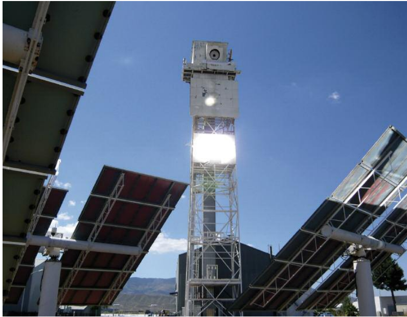
Abbildung 4 Solarthermische Wasserstoffproduktion auf einem Solarturm der Plataforma Solar de Almería
