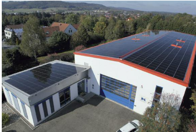
Abbildung 3 Dachanlage auf einer Gewerbehalle in Turnau mit a-Si/μ-Si-Modulen (Foto: Inventux)
