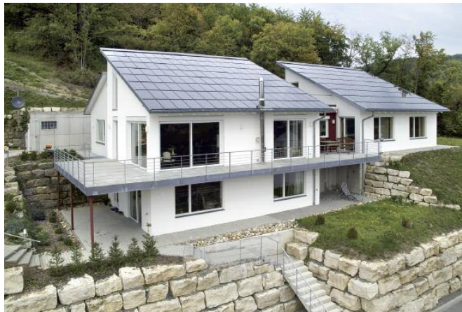
Abbildung 4 Dachintegration von CIGS-Modulen (Foto: Würth Solar)
