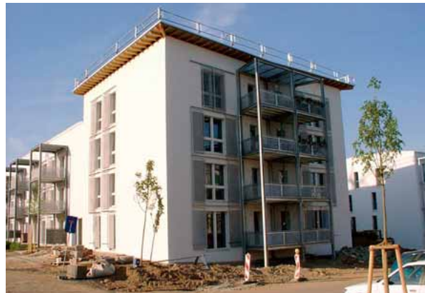
Abbildung 2a Passivhaus Kassel [1,2,3]
