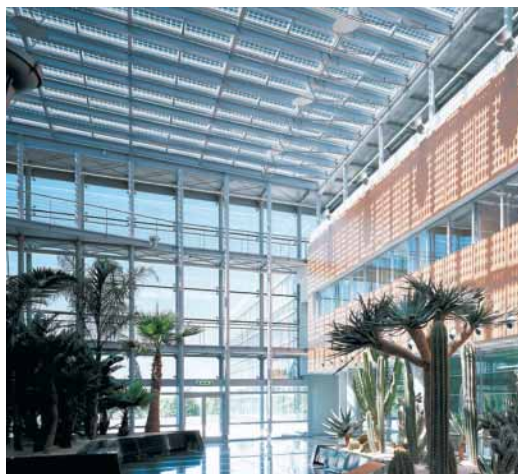
Abbildung 6 Die gebäudeintegrierte Photovoltaik der Fa. STMicroelectronics mit einer Gesamtleistung von 33 kWp wurde mit dem Schweizer Solar- preis 2003 ausge- zeichnet.
