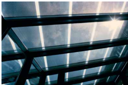
Abbildung 5 Semitransparentes Glasdach
