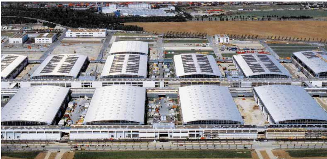
Abbildung 2 PV-Anlage von Siemens Solar mit einer Leistung von 1 MW p auf dem Messegelände in München-Riem [3].
