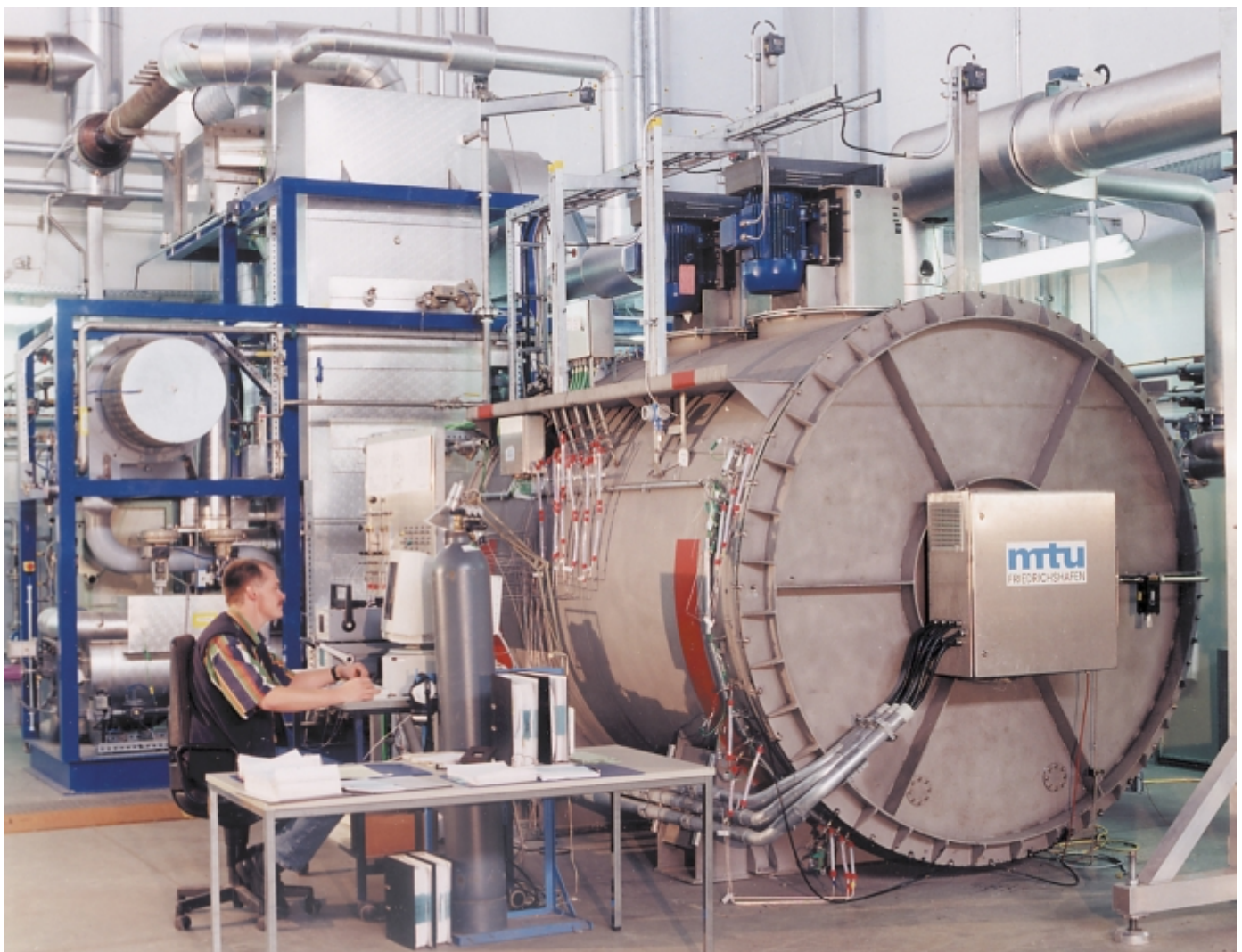
Abbildung 3: Test eines 280 kW el MCFC-Stacks in einer Versuchsanlage bei der Ruhrgas AG in Dorsten
