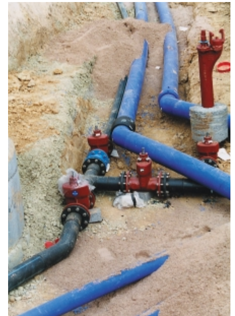
Abbildung 5: Kostengünstige Rohrverlegetechniken des Niedertemperatur-Nahwärmenetzes
