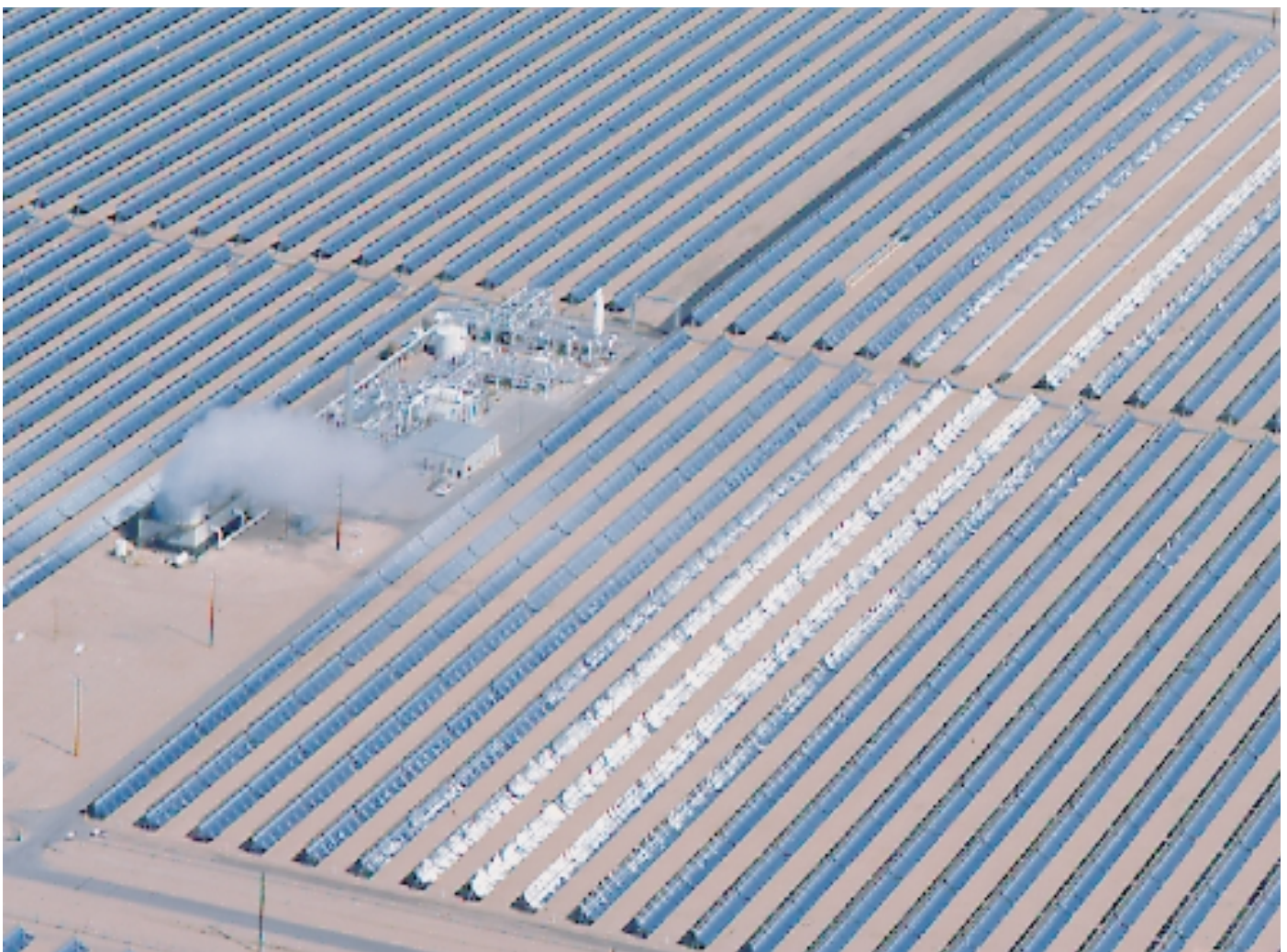
Abbildung 1: Ein 30 MW Block der Parabolrinnen-Solkraftwerke in Kramer Junction, Kalifornien
