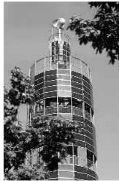
Abbildung 3 CIS-Fassadenmodule am Solarturm Heilbronn (160 Module, ca. 8 kW p )
