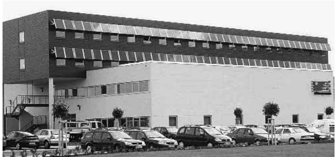
Abbildung 5 Installation „Würth Elektronik Waldenburg“ mit nachgeführten Modulen zur Energiege- winnung und Verschät- tung (80 Module 115 cm x 120 cm, ca. 8 kW p )
