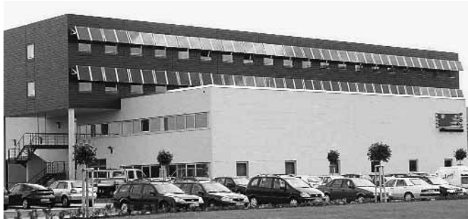
Abbildung 5 Installation „Würth Elektronik Waldenburg“ mit nachgeführten Modulen zur Energiege- winnung und Verschät- tung (80 Module 115 cm x 120 cm, ca. 8 kW p )
