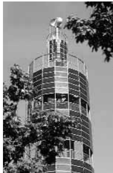
Abbildung 3 CIS-Fassadenmodule am Solarturm Heilbronn (160 Module, ca. 8 kW p )
