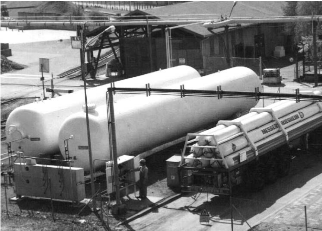
Abbildung 2 Stationäre und mobile Druckbehälter
