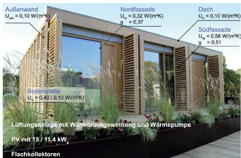
Abbildung 2 Solar Decathlon Sieger 2007 der Technischen Universität Darmstadt, Prof. Hegger, mit Angabe technischer Kennwerte
