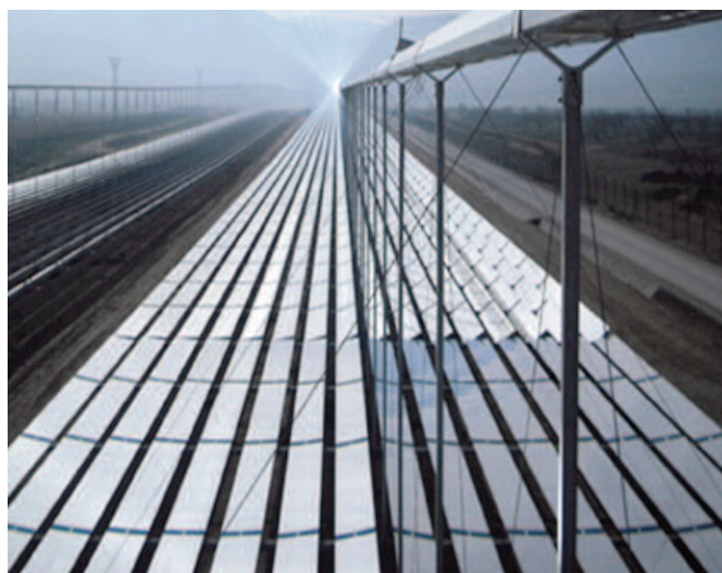
Abbildung 3 Kollektorfeld des ersten solarthermischen Kraftwerkes mit solarer Direktverdampfung in der Nähe von Murcia (Foto: Novatec-Biosol)
