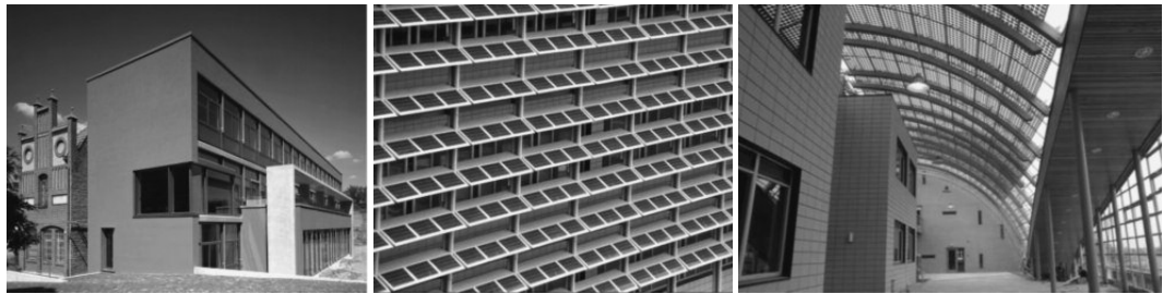
Abbildung 2 Das Zentrum für Umweltbewusstes Bauen in Kassel (links), PV-Fassade des ECN Gebäudes 31 (Mitte) und Wintergarten mit PV des ECN Gebäudes 42 (rechts)
