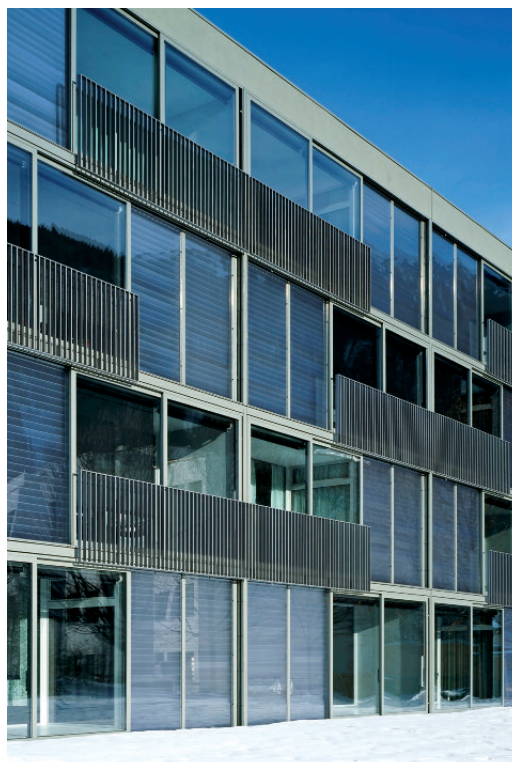
Abbildung 4 Projekt Alterswohnen in Domat/Ems mit solarer Umweltwand GlassXcrystal inkl. 20 mm
