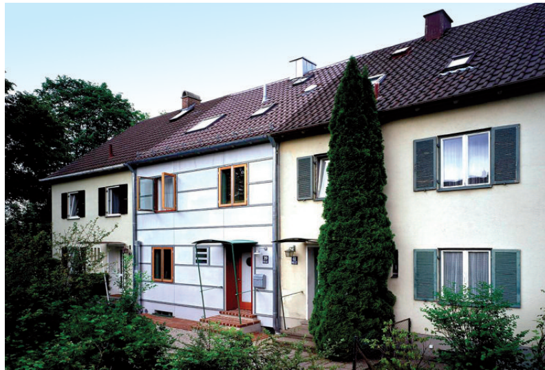
Abbildung 1 Sanierung eines Reihenmittelhaus in München, Architekt: F. Lichtblau (2001); VIP-Elemente, Gesamtdämmstärke 9 cm, U = 0,15 \text{ W}/ (\text{m}^2\text{K})
