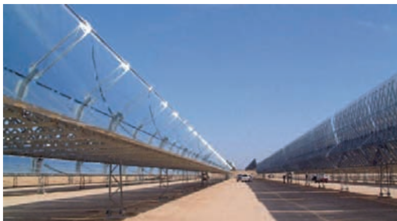
Abbildung 2 Parabolrinnen- kollektoren eines solarthermischen Kraftwerkes
