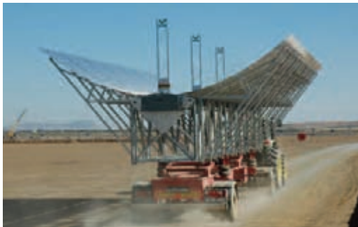
Abbildung 6 Transport eines montierten Kollektor- elementes in das Solarfeld
