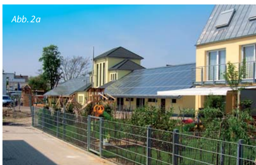
Abbildung 2a und 2b Projekt „Am alten Schlachthof“ in Speyer: Kollektordächer und Pufferspeicher- aufstellung (2b)
