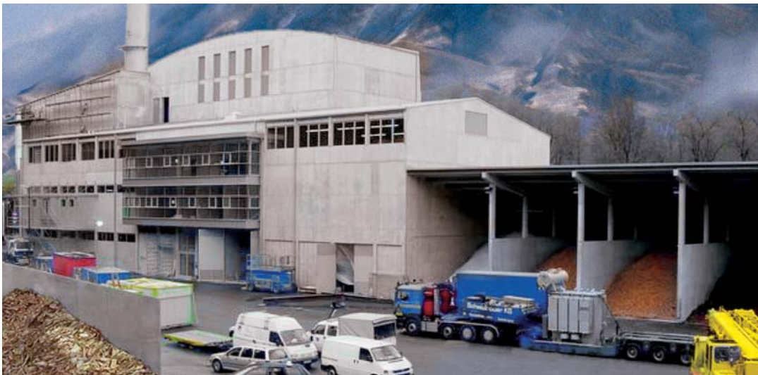
Abbildung 3 Biomasse-Nutzungs- anlage für Strom und Wärme
