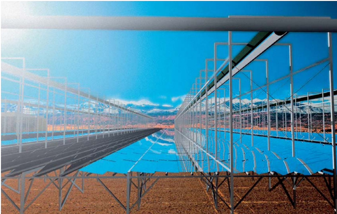
Abbildung 3 Animation eines linearen Fresnelkollektors zur Heißdampferzeugung
