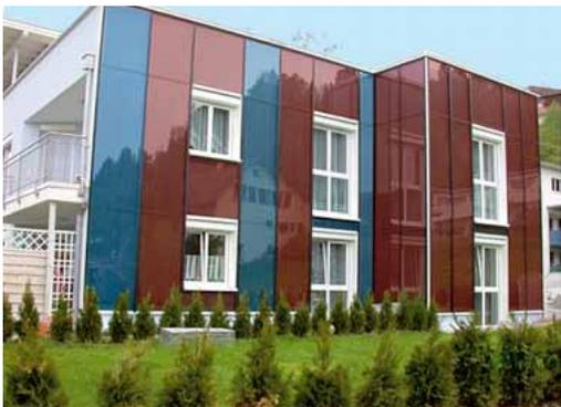
Die Entwicklung von farbigen selektiven Absorbern erweitert gerade beim Einsatz in der Sanierung die Anwendungsmöglichkeiten von fassadenintegrierten Warmwasserkollektoren [5]. Bei dieser Maßnahme ist allerdings unbedingt auf die Feuchtebilanz in der dann dampfdichten Hülle zu achten.
