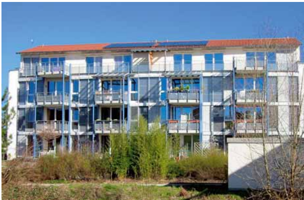
Abbildung 1a Solarhaus Gundelfingen [1, 2, 3]
